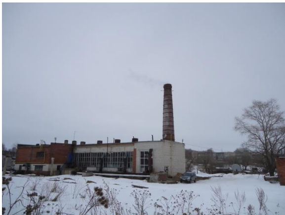
Центральная котельная села
